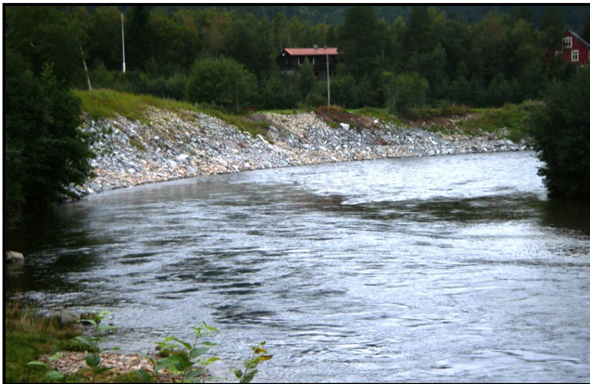
Bilde 8. Denne elveforbygningen i Toåa i Surnadal ble etablert etter storflommen i august 2003, da utgraving av elvemelen gjorde at en lokal vei ble sterkt rasutsatt. Foto: Gunnbjørn Bremset.
